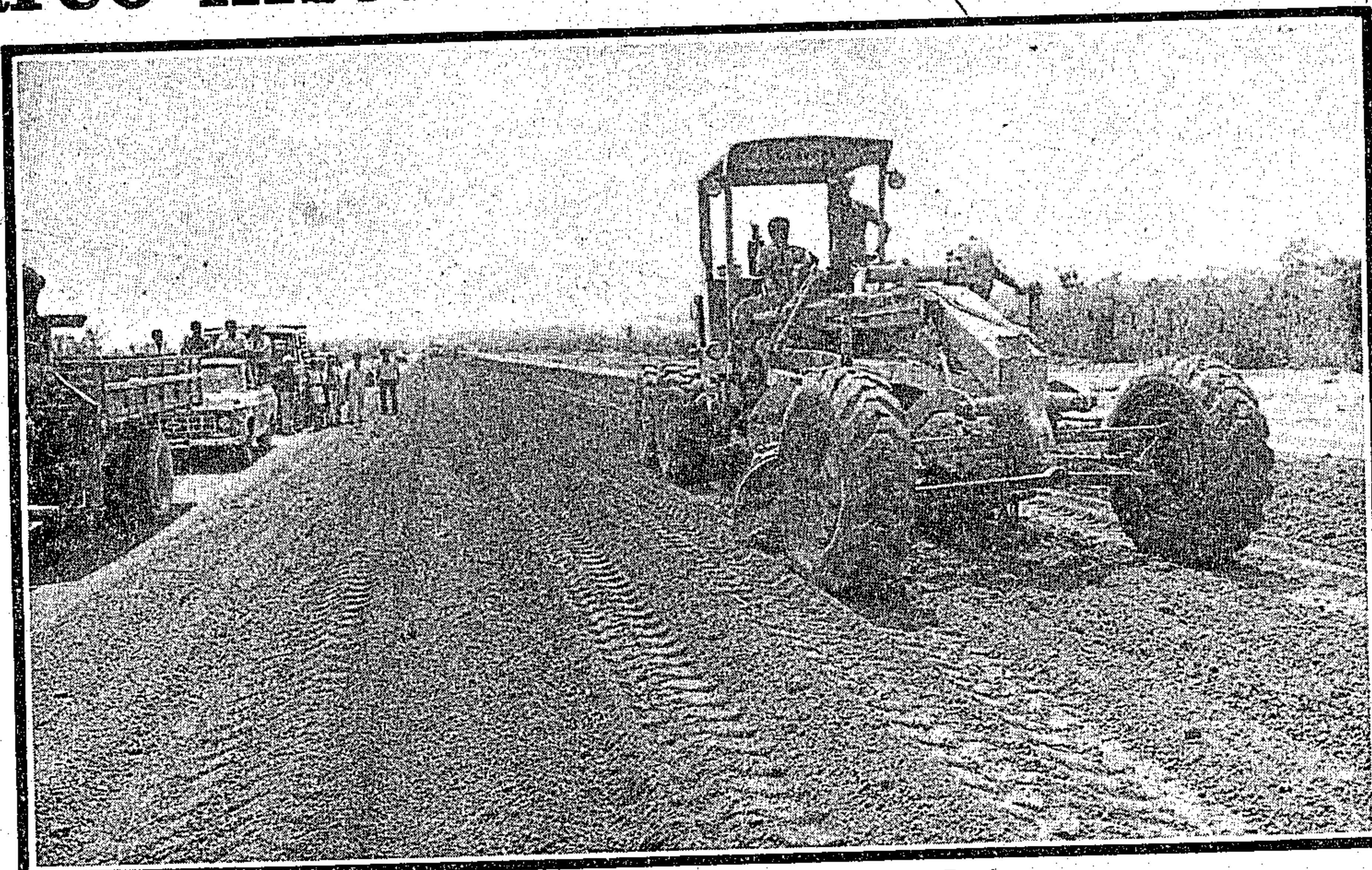
O começo dos trabalhos de pavimentação da importante rodovia do sul do Pará
