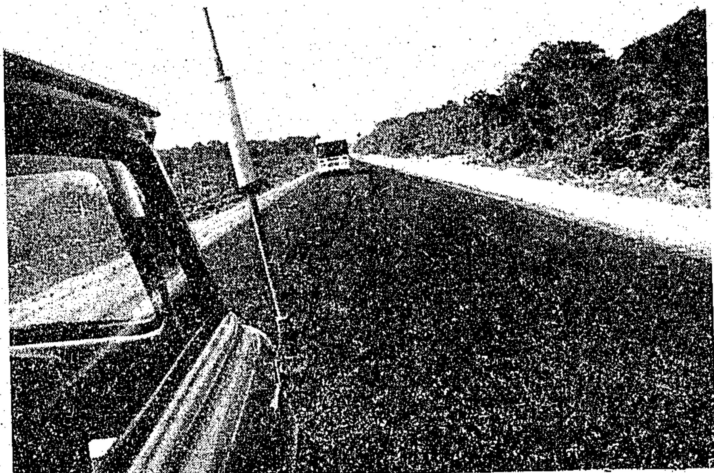
Um trecho já pavimentado da importante rodovia
