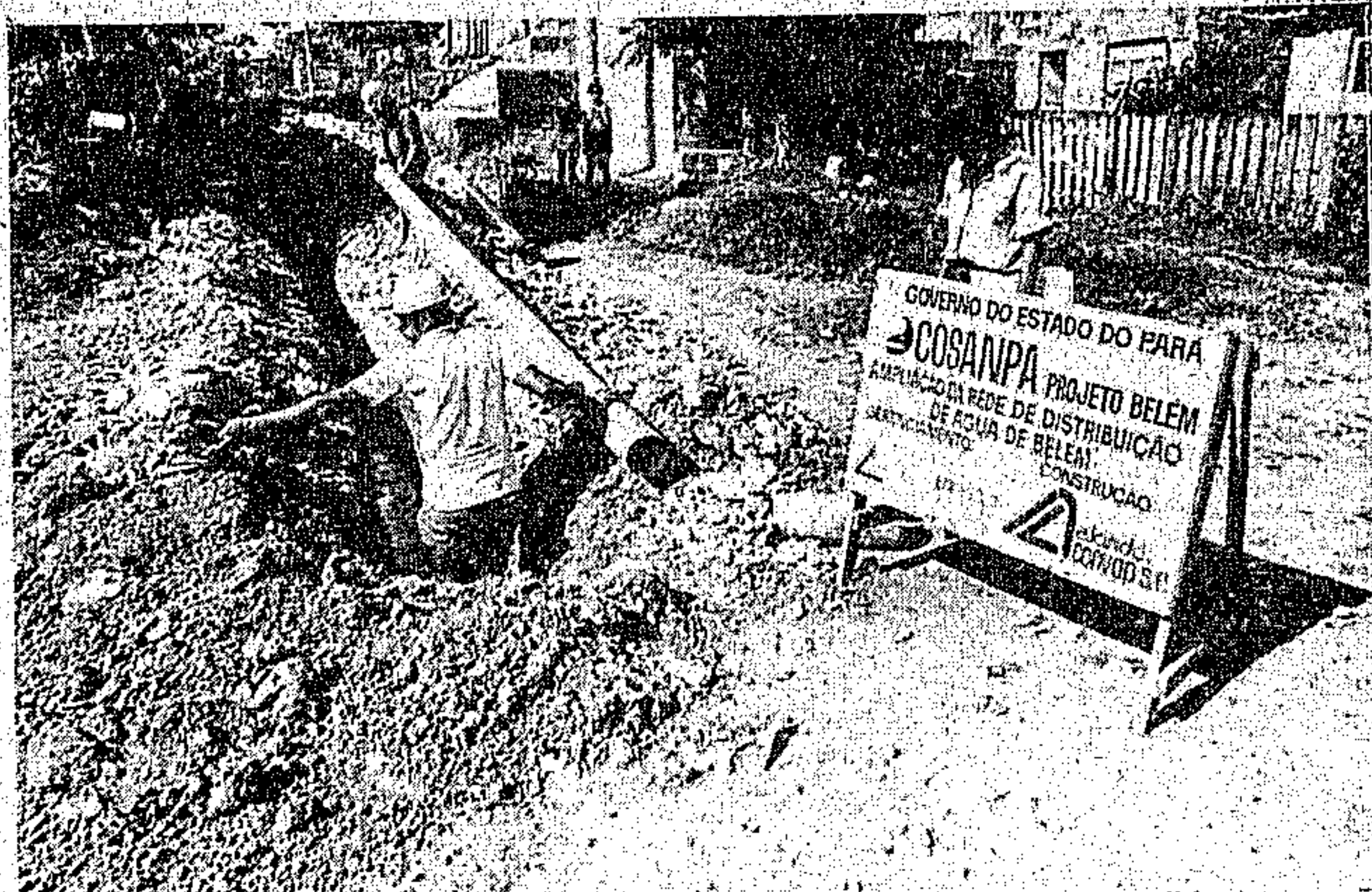
Em outubro, foram assentados 12.053 metros de tubulação
