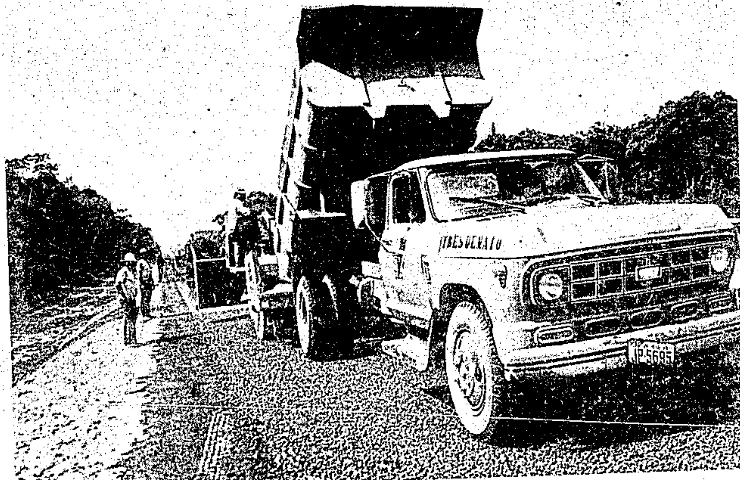
Do Fundepará, foram alocados recursos para a pavimentação da PA-150
