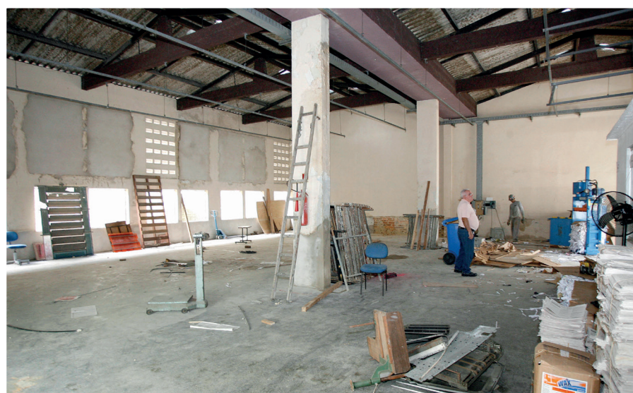
Detalhe das obras no local onde será instalada a nova gráfica.
